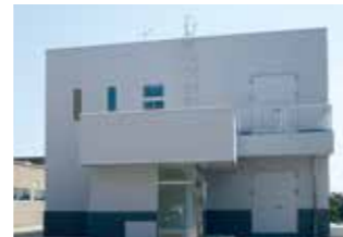
[新築・施工] 管理事務所 ■ 小松市中央浄化センター 水処理制御棟
