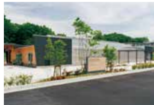
[新築・施工] 体験施設 ■ 木場潟公園 農業体験ハウス
