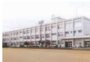
[改修・施工] 学校 ■ 小松市立中海小学校
