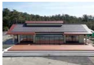
[改修・施工] 観光施設 ■ 安宅ビューテラス
