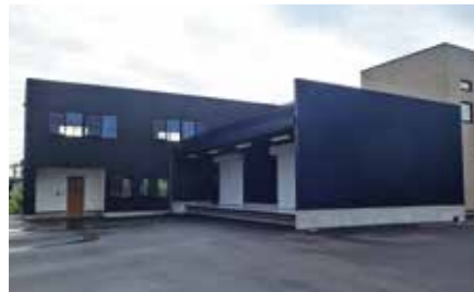
[新築・設計施工] 事務所・倉庫 ■ C社 金沢事務所
