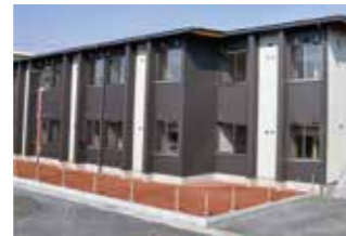
[新築・施工] 共同住宅 ■ 小松市営木曾町住宅 (1工区A棟)
