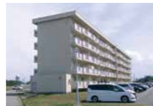
[改修・施工] 共同住宅 ■ 防衛局 小松日末宿舎
