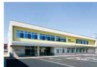
[新築・施工] 福祉施設 ■ 能美市ふれあいプラザ
