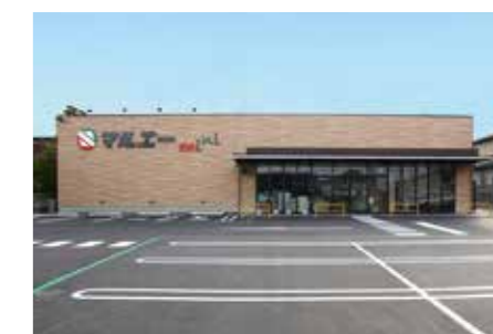
[新築・施工] スーパーマーケット ■ マルエーミニ 美川店
