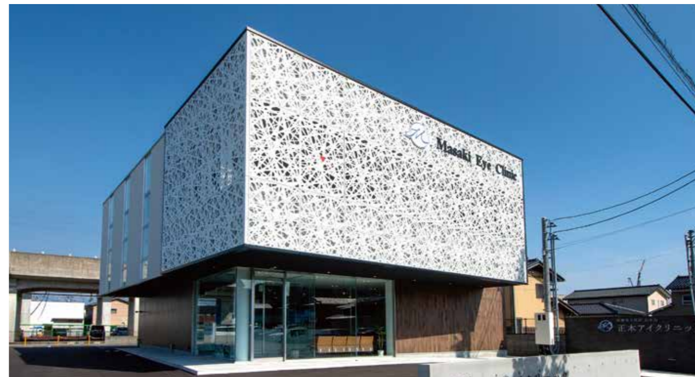
[新築・施工] 医療施設 ■ 正木アイクリニック
