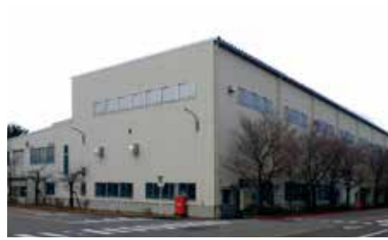
[新築・施工] 工場 ■ K社 組立工場
